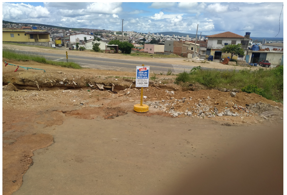
Um terreno privado tem sido utilizado pelos motoristas para transitar pela Rua Santa Quitéria – interrompida por uma cratera produzida pelas chuvas – no Bairro Nossa Senhora Aparecida.
