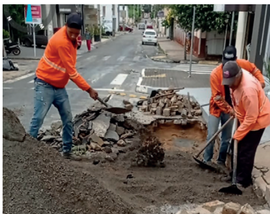
A recuperação de vias públicas foi imediatamente iniciada pela Secretaria Municipal de Infraestrutura.
