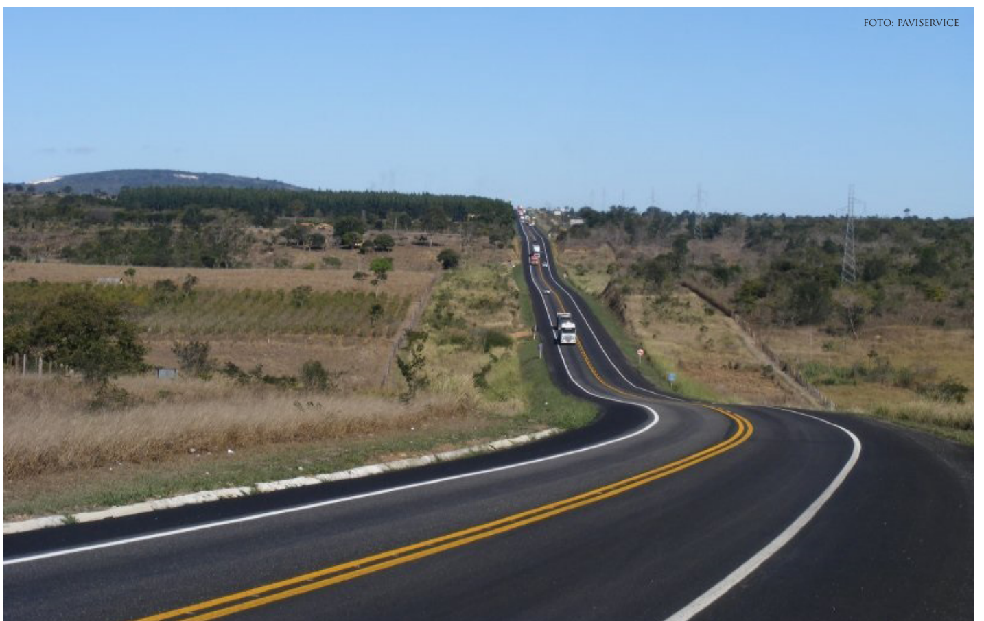
A Rodovia BR-116, privatizada em 2009, deveria ter sido duplicada, conforme Contrato de Concessão, desde 2009.
