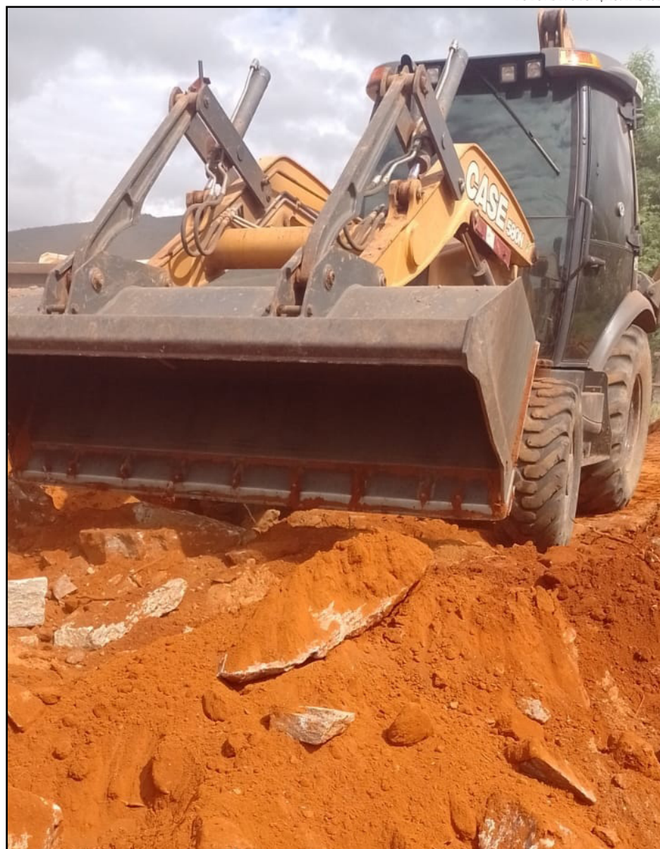
Máquina de empreiteira avança na remoção de terra para cima da cerca da área de propriedade da Fadesb.
