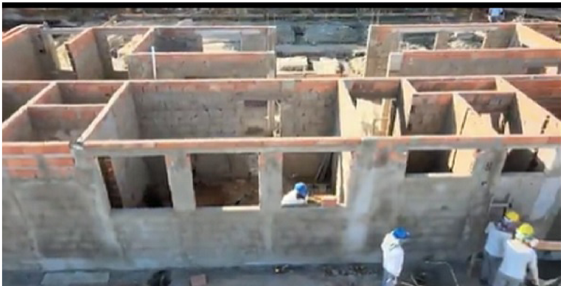
As obras de construção do Complexo Policial de Tremedal avançam e a previsão é que estejam concluídas ainda este ano.
