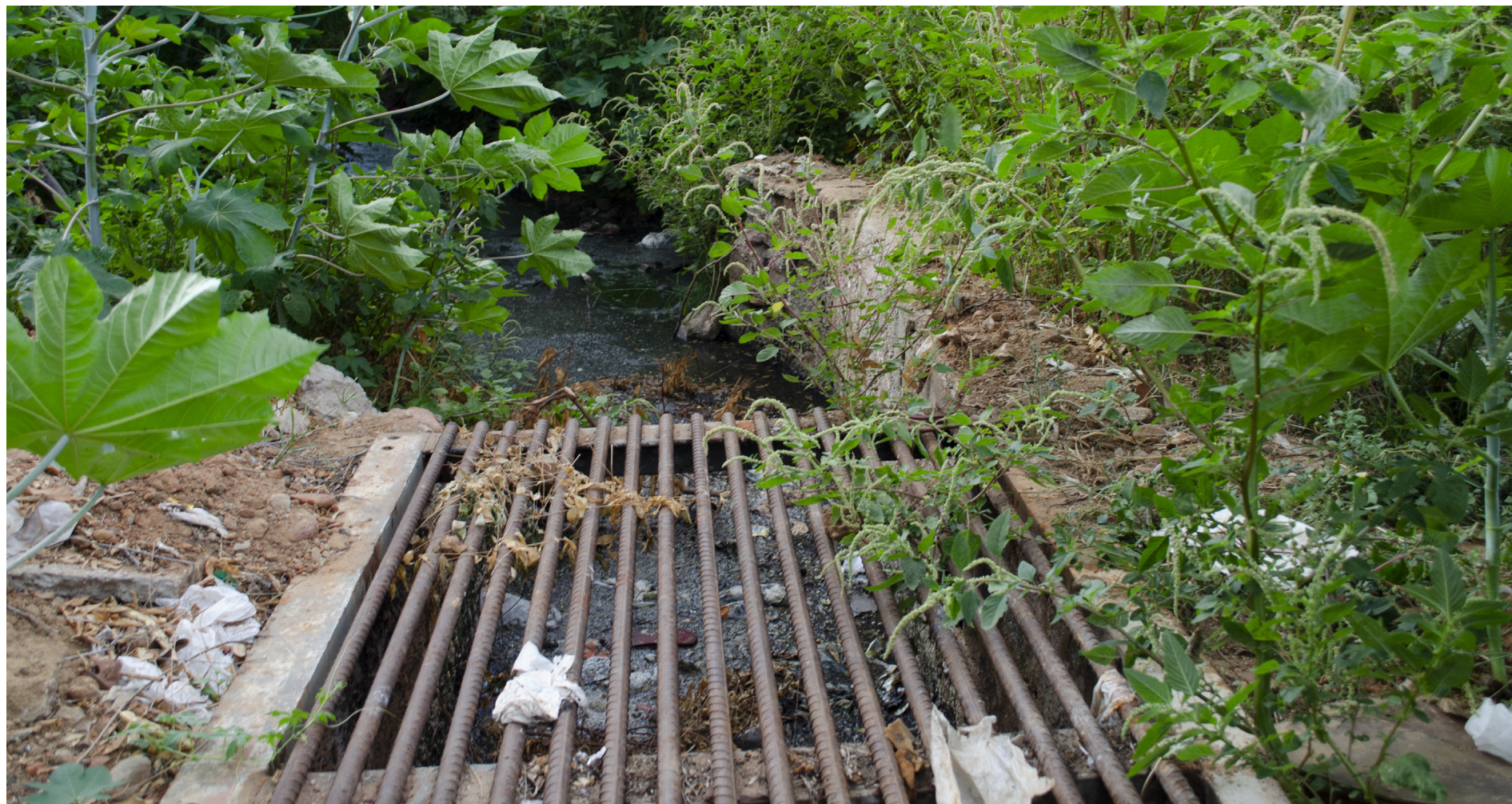
Matagal e esgoto a céu aberto fazem parte da paisagem do Bairro Irmã Dulce, colocando em risco a segurança e a saúde dos moradores.
