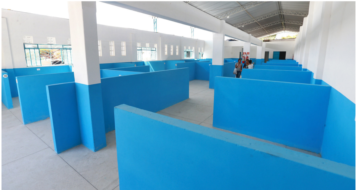
Requalificado, o Galpão Multi Variedades vai beneficiar diretamente 102 feirantes.
