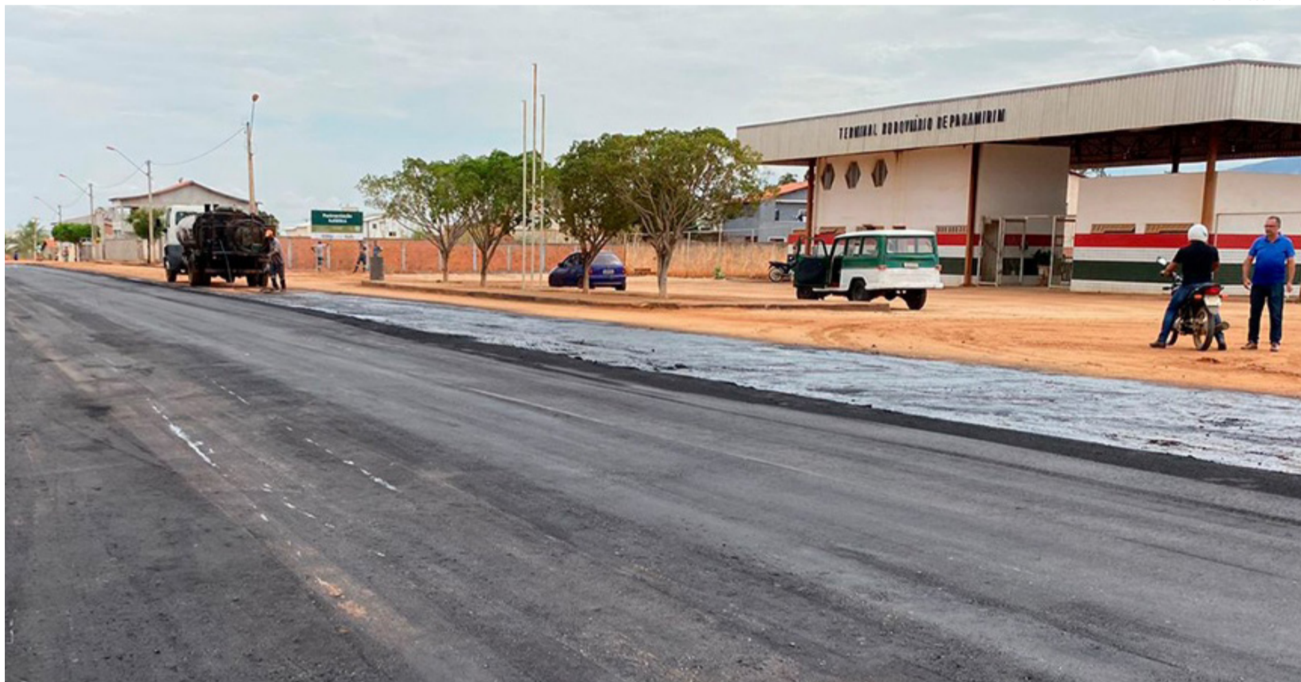
A Avenida Dr. Júlio Bernardo é uma das vias que está sendo pavimentadas pela Codevasf em Paramirim.
