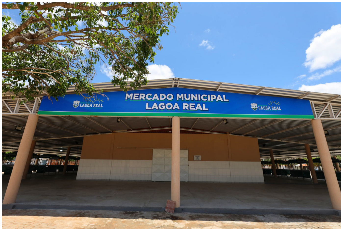
Na requalificação do Mercado Municipal, o Governo do Estado investiu R$ 1,1 milhão.
