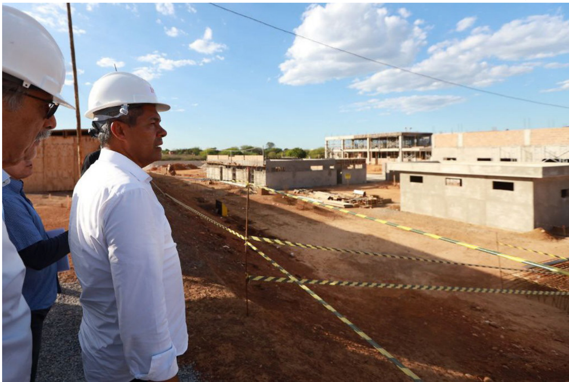
O governador Jerônimo Rodrigues visitou o canteiro de obras da Escola Estadual de Tempo Integral.
